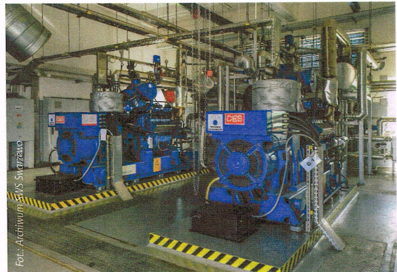
FOT. 3 Kogeneratory z osprzętem i armaturą ciepłowniczą wraz z oznaczeniem stref niebezpiecznych
